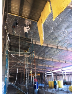
Cách nhiệt cho trần nhà. Insulation for the ceiling.
