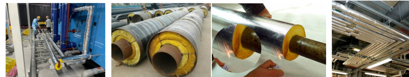
Bọc cách nhiệt cho đường ống hơi, ống chiller, ống đồng..
